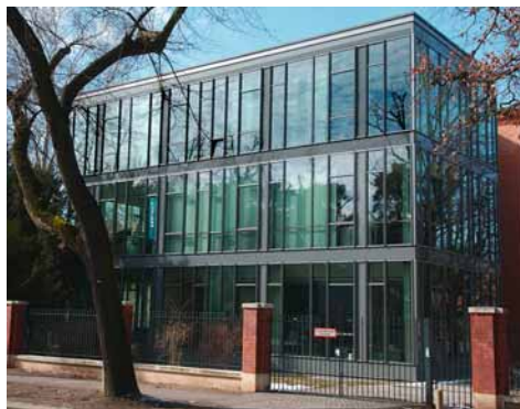
Gebäude des Play-Out-Centers in Potsdam
