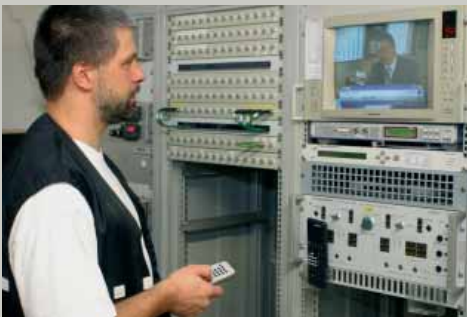
Kontrollstelle für den DVB-T-Empfang im Berliner Fernsehturm
